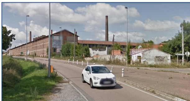
Vue de l'ancienne tuilerie, avant démolition, depuis la RN7
