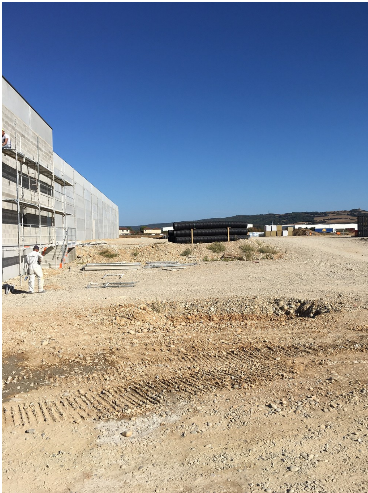
Illustration 2: Vue n°1 de la plateforme où est projetée la C4, encore en travaux
