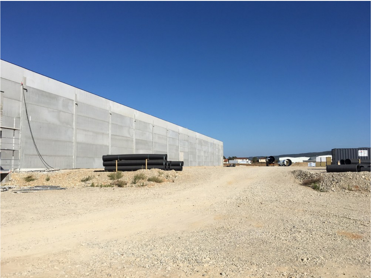
Illustration 3: Vue n°2 de la plateforme où est projetée la C4, encore en travaux
