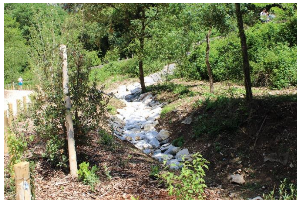
▲ Noues en bordure des descentes amonts principales et avaloirs pouvant être mieux intégré au lieu et nécessitant un entretien afin de ne pas être bouché, grilles venant d'être installées au niveau des toilettes secteur aval
