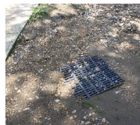
▲ Noues en bordure des descentes amonts principales et avaloirs pouvant être mieux intégré au lieu et nécessitant un entretien afin de ne pas être bouché, grilles venant d'être installées au niveau des toilettes secteur aval
