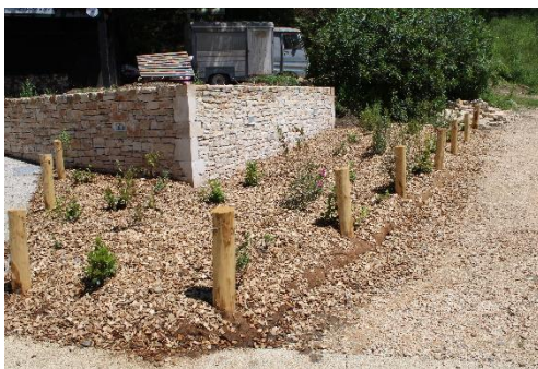
▲ Mesure de protection temporaire à retirer quand végétation dominante : piquet en biais, poteau bois et fil acier, ganivelle
