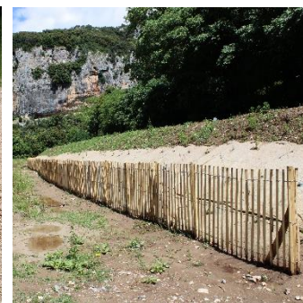
▲ Mesure de protection temporaire à retirer quand végétation dominante : piquet en biais, poteau bois et fil acier, ganivelle
