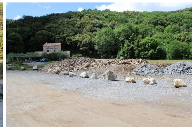
▲ Tas de matériaux issus des phases chantiers sur le P2, première image des visiteurs
