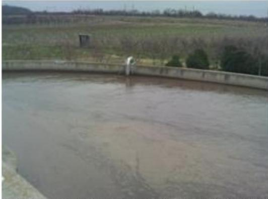
*Le bassin d'aération par insufflation d'air. Il est équipé de pales assurant la circulation des boues aérées dans le sens anti-horaire.*
