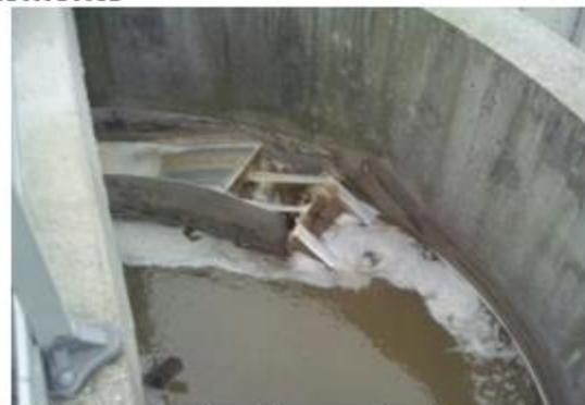
*Le dégraisseur – dessableur, raclage des graisses en
