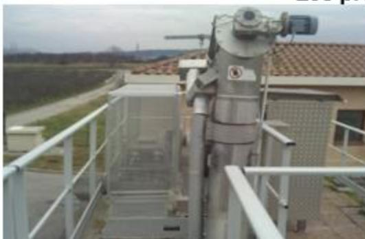
*Le dégrillage automatique (à gauche) et le dispositif
