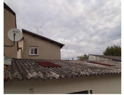
Toiture: Environ 250m<sup>2</sup> Toiture plaques amiante ciment, Analyse P42: AMI1310-6854-1, Résultat : PRESENCE D'AMIANTE
