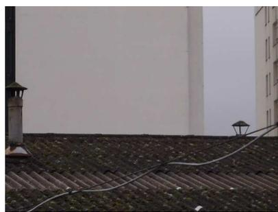
Bât D : Toiture: Environ 150m<sup>2</sup> Toiture plaques amiante ciment, Résultat : PRESENCE D'AMIANTE sur décision de l'opérateur
