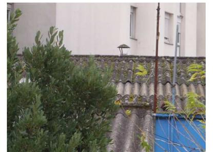
Bât C : Toiture: Environ 300m<sup>2</sup> Toiture plaques amiante ciment, Analyse P9: AMI1310-6965-1, Résultat : PRESENCE D'AMIANTE
