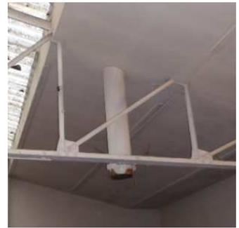
Bât C: C1: Environ 3ml Conduit amiante ciment débouche en toiture, Résultat : PRESENCE D'AMIANTE sur décision de l'opérateur
