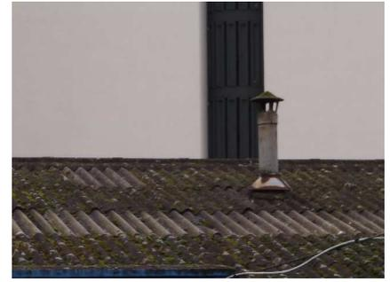
Bât C : Toiture: Environ 2x1ml conduit+chapeau amiante ciment, Résultat : PRESENCE D'AMIANTE sur décision de l'opérateur
