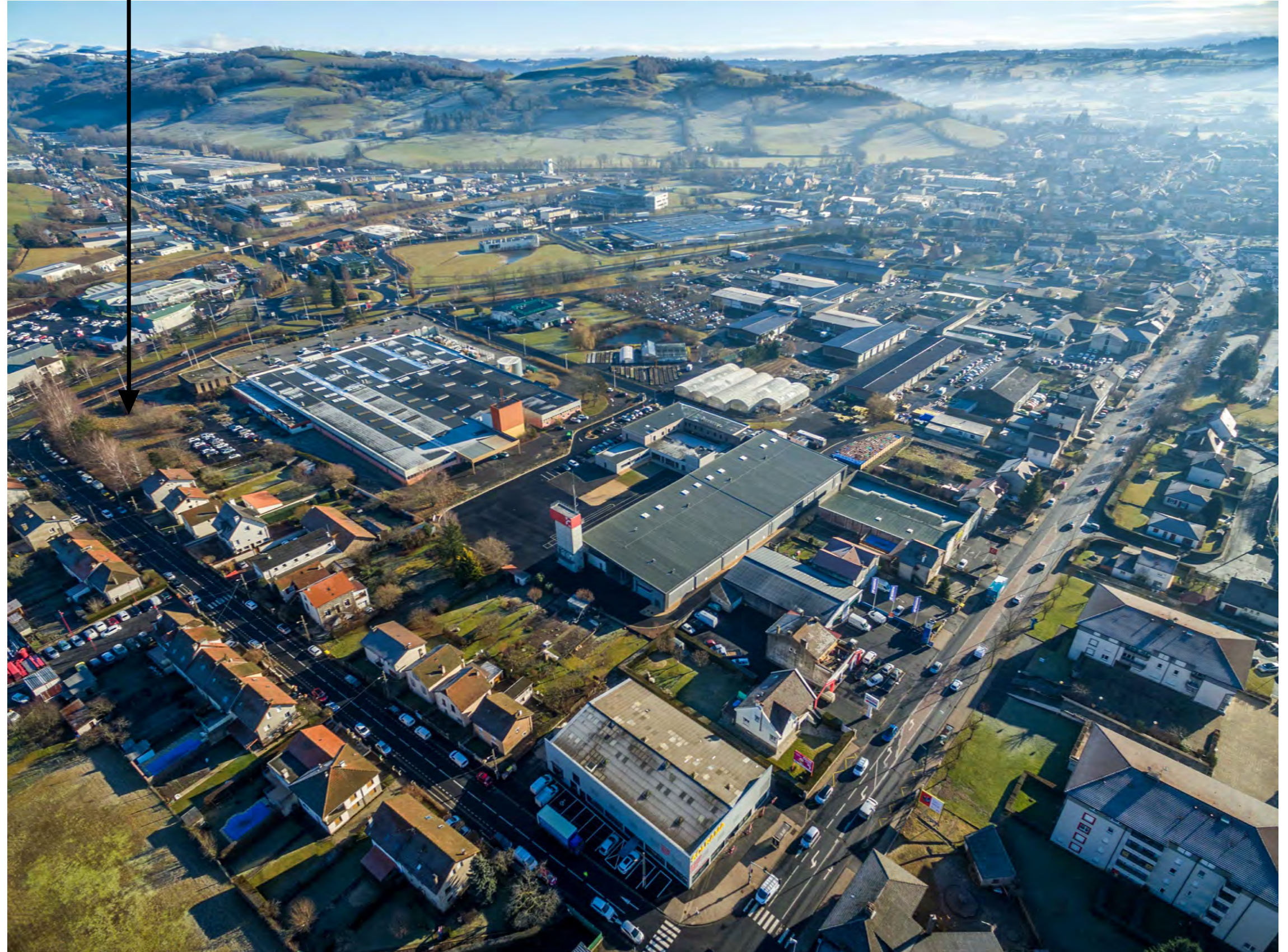
VUE 2 - DEPUIS LE QUAI DE LIVRAISON WELDOM
