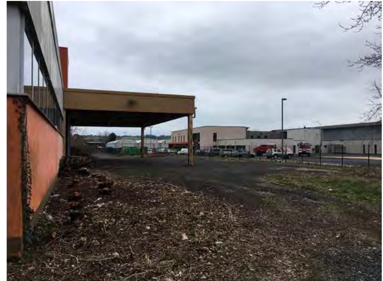
Entrepôt existant à réalibérer, futur accès camion
