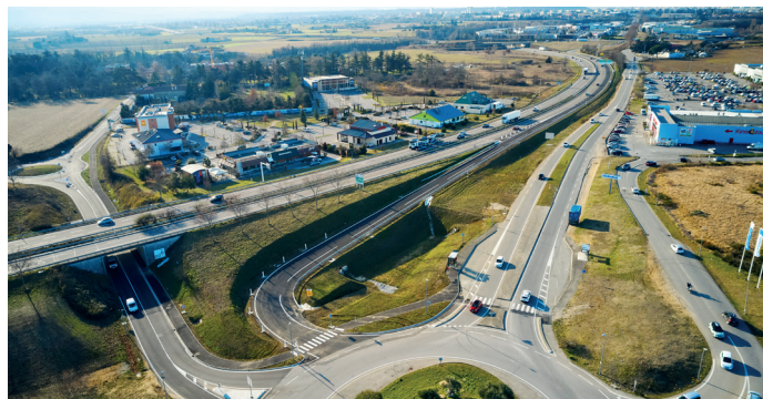
La nouvelle bretelle d'insertion vers la RN532 (vue vers le sud-ouest)
