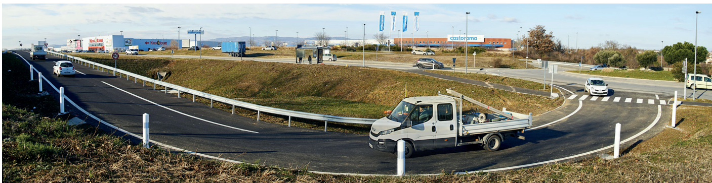
Des déplacements facilités grâce à la nouvelle bretelle
