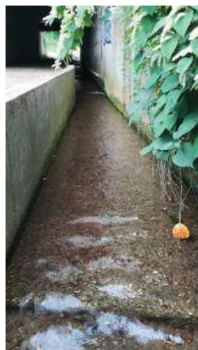
Figure 29 : Radier du pont de la RN88 sur le Janon à 125 m en amont de sa confluence avec le Ricolin
