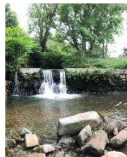
Présence d'un seuil infranchissable
