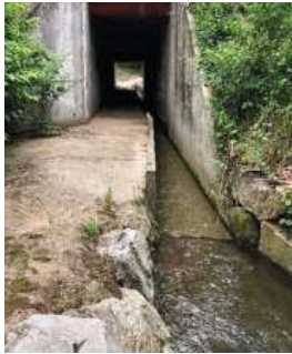
Franchissabilité piscicole limitée dans l'ouvrage de la RN88 (Janon)
