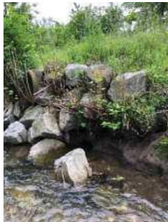
Protection de berges en enrochements effondrés
