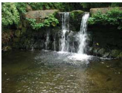
Figure 28 : Seuil occasionnant une rupture de la continuité écologique du Janon à 40 m en aval de sa confluence avec le Ricolin
