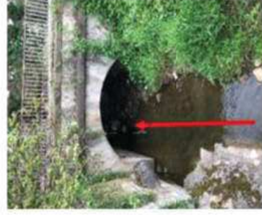
Figure 80 : Vue amont de l'OH 100 sur le Ricolin
