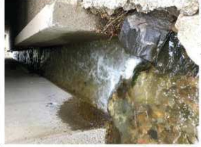
Figure 62 : Photo terrain de la chute en amont de l'OH 4621 (RN88)
