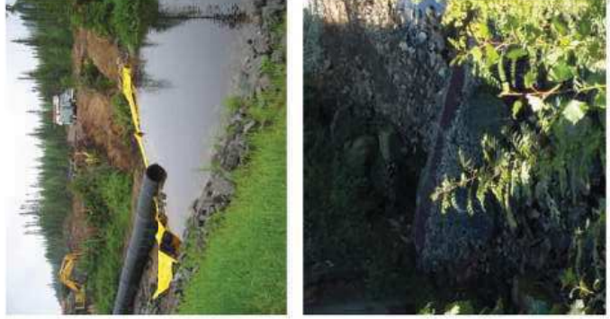
Figure 47 : Illustrations de barrage souple autobloquant et filtre
