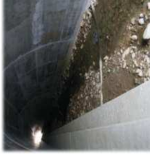
Figure 65 : Illustration de banquettes béton à l'intérieur d'un ouvrage
