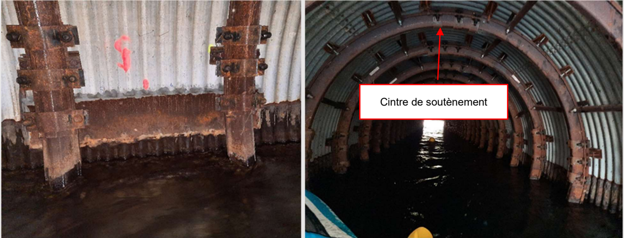
Photos de l'ouvrage après confortement provisoire
