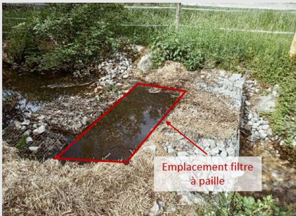
Figure 22 – Exemple de filtres mixtes : gabions et paille au centre
