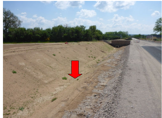
Banquette hors d'eau au sein de la noue avant végétalisation
