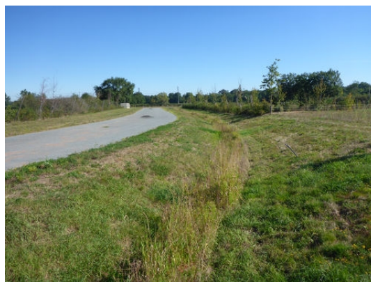
Voirie et noue végétalisée
