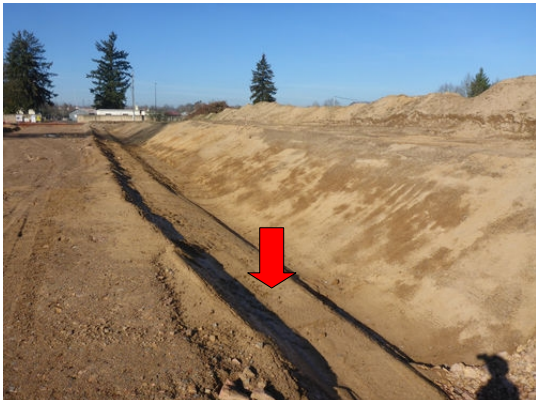
Aménagement de la banquette hors d'eau au sein de la noue
