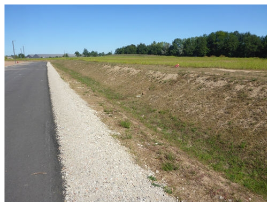
Noue avec banquette en cours de revégétalisation
