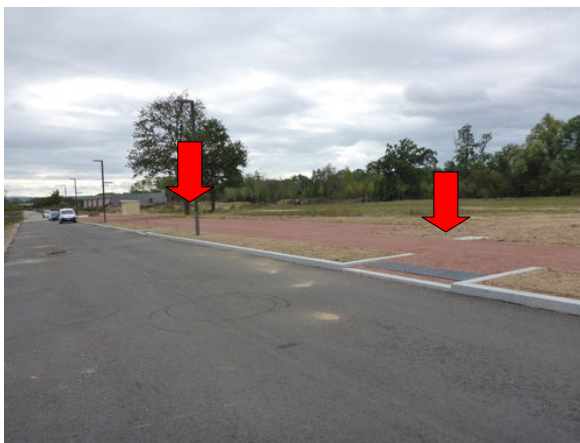
Abaissement de la bordure de trottoir au niveau du corridor de passage de la petite faune
