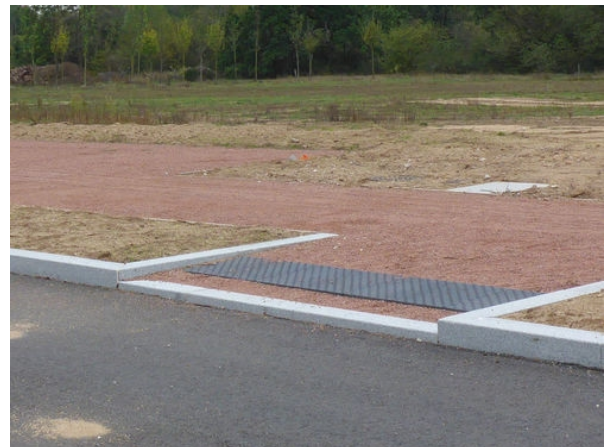
Abaissement local de la bordure de trottoir pour favoriser le passage (Octobre 2019)
