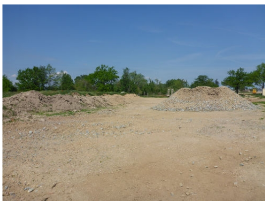
Dépôt temporaire de matériaux du chantier
