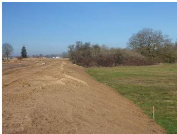
Respect des limites de chantier par rapport à la zone humide n°3
