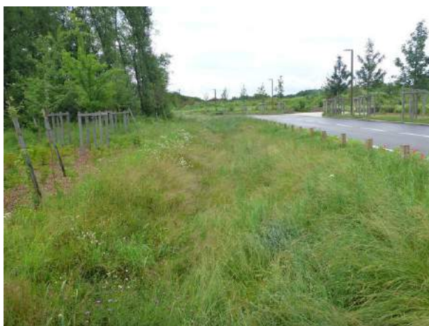
Noue de l'axe secondaire réalisée en phase 2 (juin 2018)
