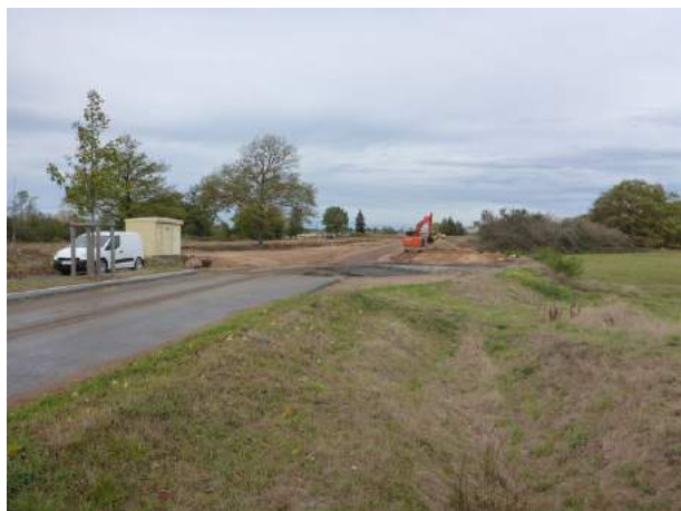
Début du chantier de prolongement de l'axe secondaire
