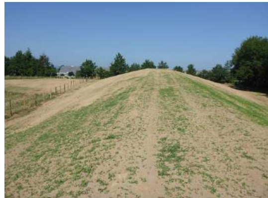
Secteur d'enfouissement de la Renouée après les travaux (03/08/2017)
