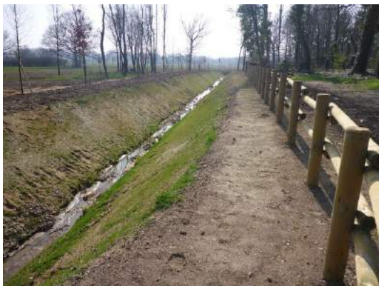
Fossé du Merlin réaménagé en 2016 (14/03/2017)
