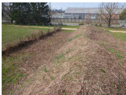
Station de Renouée du Japon déjà présente sur le secteur d'enfouissement (14/03/2017) avant travaux
