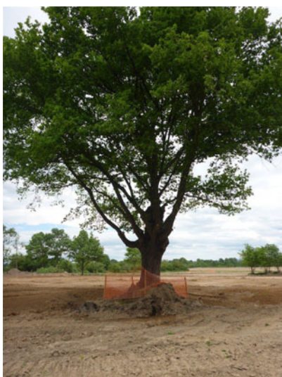
Balisage autour d'un chêne isolé au sein du chantier
