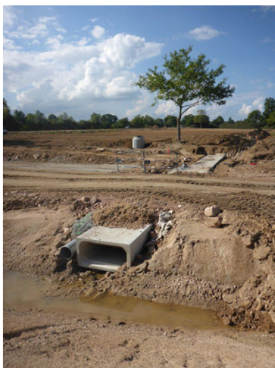
Installation du passage à faune sous la voie principale
