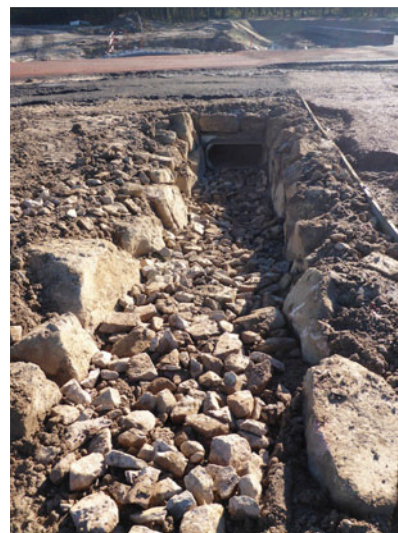
Extrémité du passage à faune sous la voie principale
