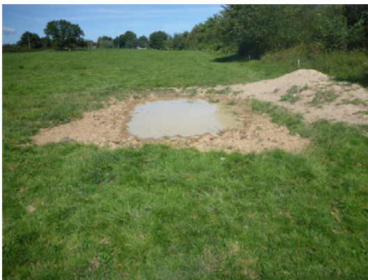
Mare n°4 (après imperméabilisation) en juin 2014
