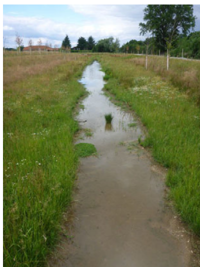
Bassin de rétention végétalisé (juin 2015)
