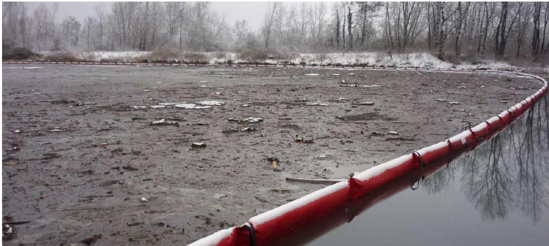
Figure 15 : Chantier test à Chamousset : barrage flottant
