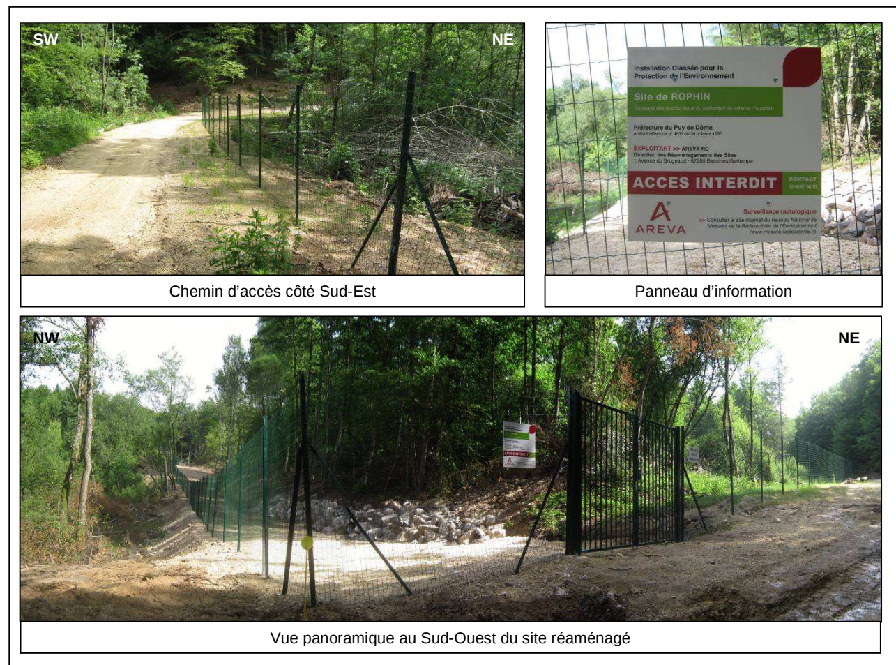
Photographies des travaux réalisés en 2010
