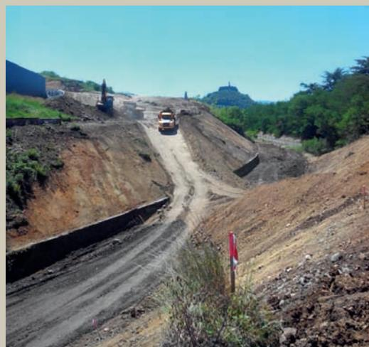
RN88 - Terrassements et mur de soutènement au-dessus de la voie ferrée et de Ste Marie
