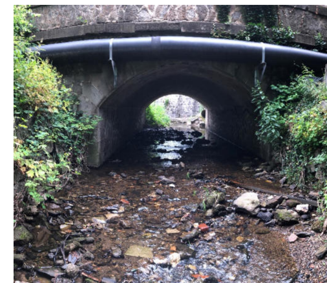
Figure 132 : Vue aval de l'OH 100 sur le Ricolin
