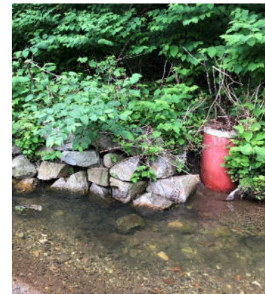
Présence du réseau d'assainissement d'EU dans le lit
