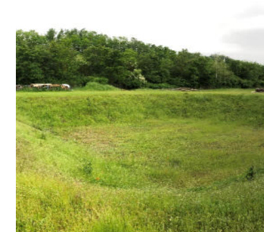
Bassin de rétention 2 de la DIRCE
