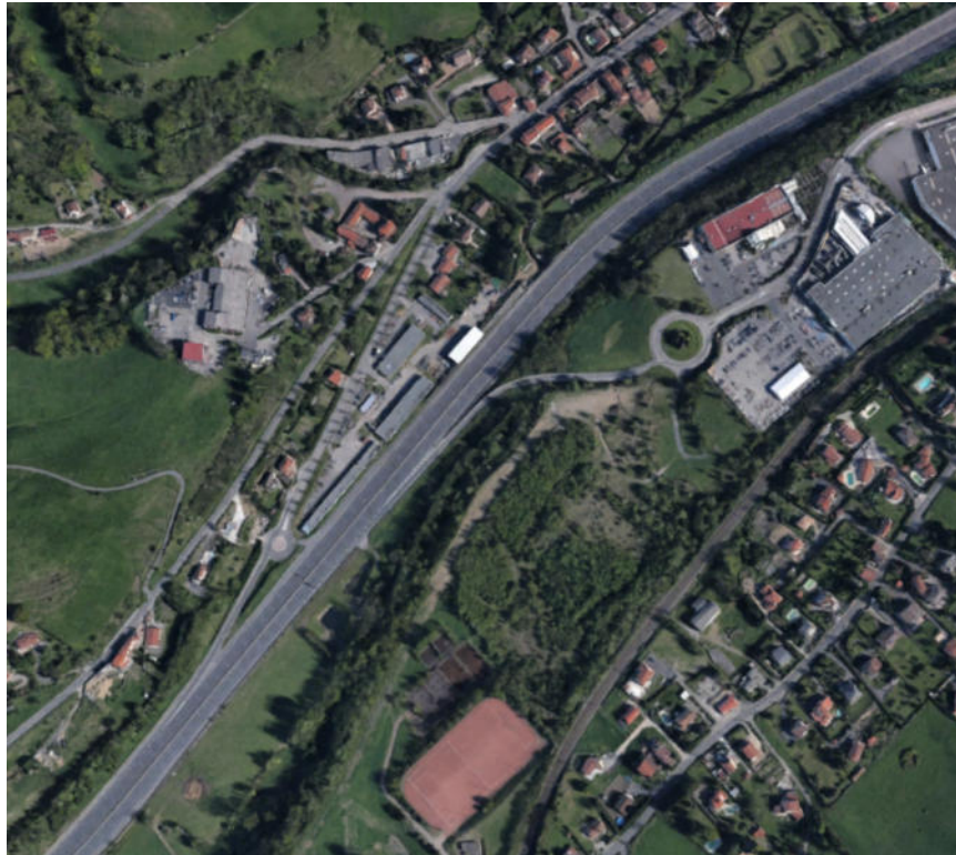
Figure 3 : Vue aérienne du demi-échangeur n°17 existant
