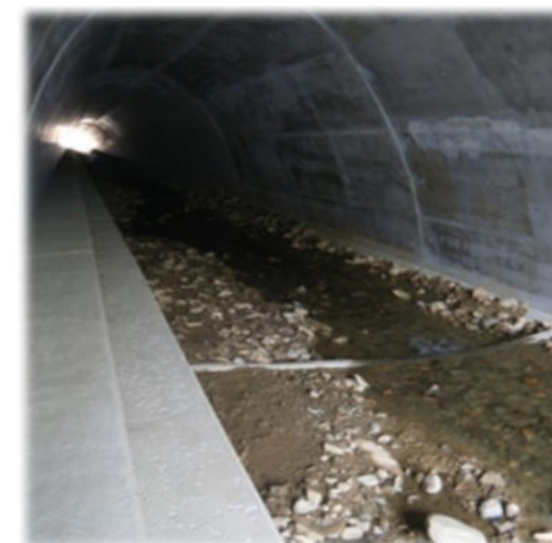
Figure 116 : Illustration de banquettes béton à l'intérieur d'un ouvrage
