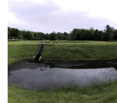
Bassin de rétention 1 de la DIRCE
