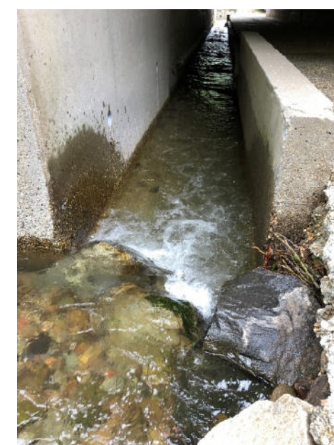
Figure 113 : Photo terrain de la chute en amont de l'OH 4621 (RN88)
