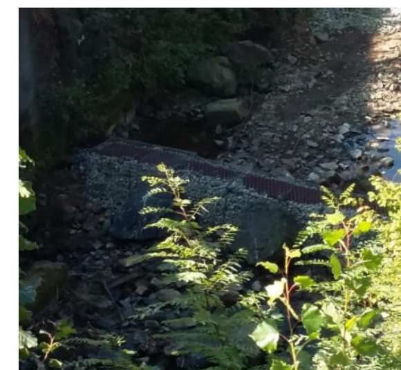
Figure 134: Illustrations de barrage souple autobloquant et filtre
