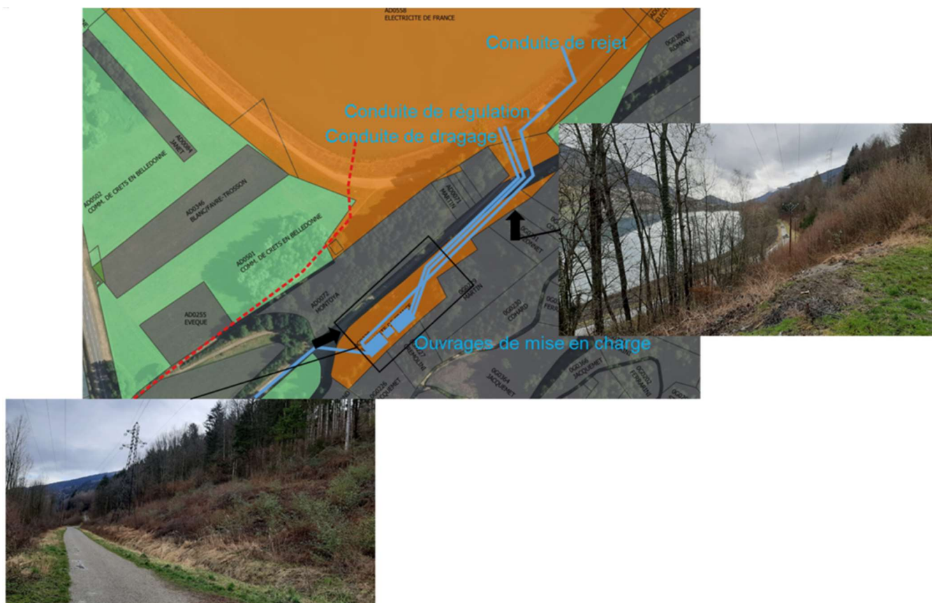
Figure 5 : Localisation des conduites amont et des ouvrages de mise en charge (en orange : les parcelles propriété EDF ou domaine public hydroélectrique, les flèches noires indiquent l'orientation des prises de vue). Les études étant toujours en cours, le positionnement de ces conduites pourra évoluer
