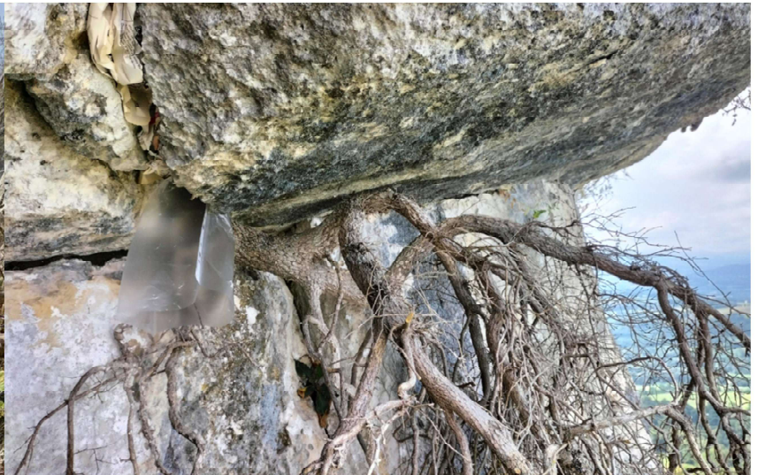
Fissure en falaise équipée d'un système anti-retour
