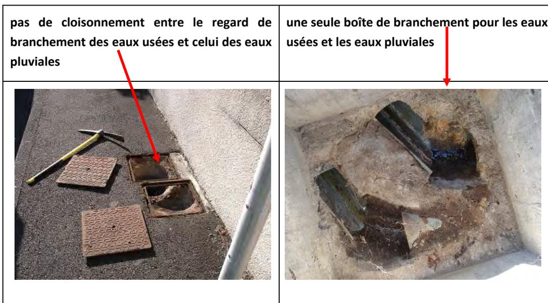
La fumée peut également se diffuser entre les regards du réseau d'eaux usées et ceux du réseau d'eaux pluviales (ouvrages non étanches). Lorsque la fumée passe du réseau d'eaux usées ou réseau d'eaux pluviales, c'est l'ensemble des gouttières, avaloirs et grilles qui laissent échapper de la fumée. Il n'est donc pas possible de conclure sur l'existence d'anomalies.
