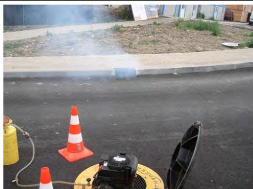
La réalisation des tests à la fumée constitue une pré-localisation des inversions de branchements *EP dans EU*. Chez les riverains chaque dysfonctionnement devra être vérifié à l'aide d'un test au colorant pour valider la nature de l'anomalie. En effet la configuration de certaines installations (une seule boîte de branchement pour les deux évacuations d'eaux usées et d'eaux pluviales) peut entraîner des passages directs de fumée de l'EU vers l'EP (voir exemple ci-dessous).
