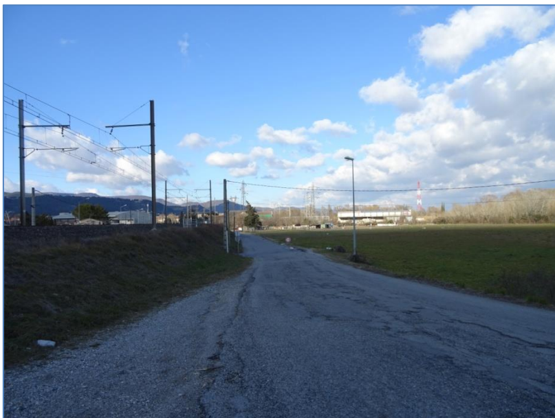
Photographie 5 – Vue sur le poste du TEIL et la zone d'étude depuis le sud
