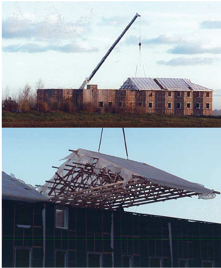
Figure 6-2 : Illustrations du bâtiment en cours de montage
