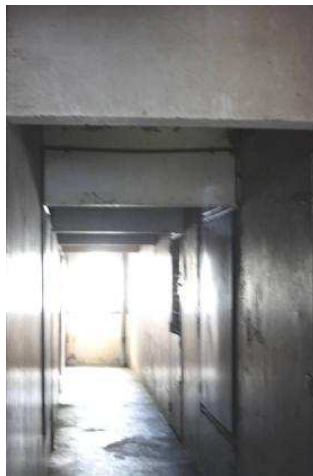
Figure 4-3 : Linteaux visibles au niveau du couloir
