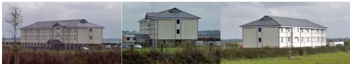
Figure 6-1 : Vues générales du bâtiment actuel
