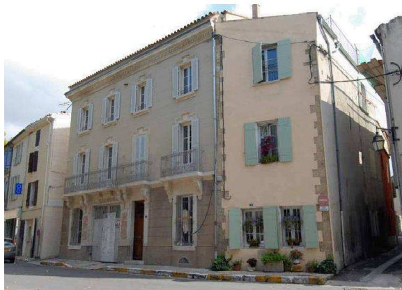
Figure 3-1 : Vue de la façade principale du bâtiment
