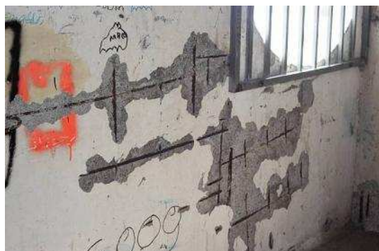
Figure 4-5 : Corrosion sur les voiles porteurs (1)
