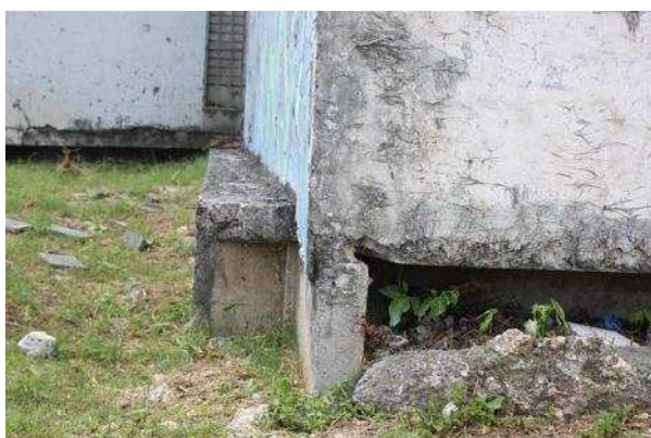
Figure 4-4 : Tassement du remblai
