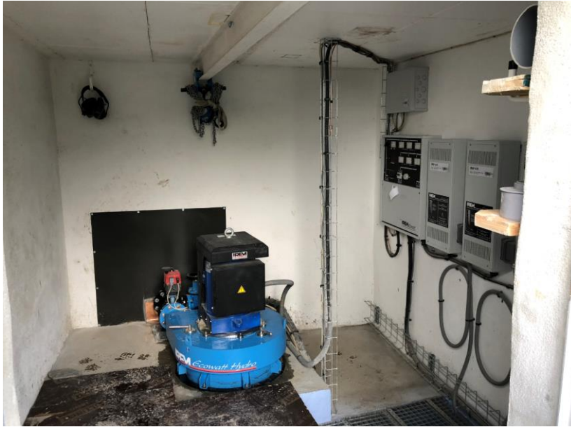
Local de la Pico-centrale
