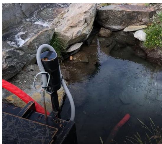
Dessableur de l'ouvrage de captage
