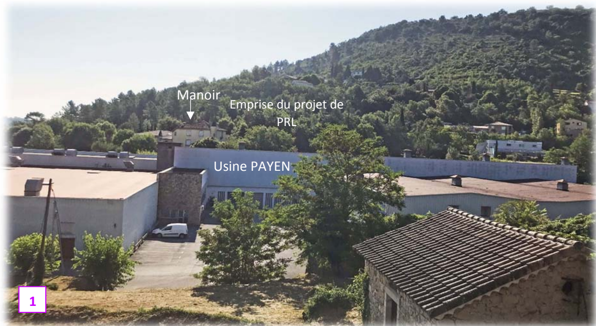
Prise de vue éloignée n°1 depuis la RD 104a (cliché IATE du 25/06/2020)
