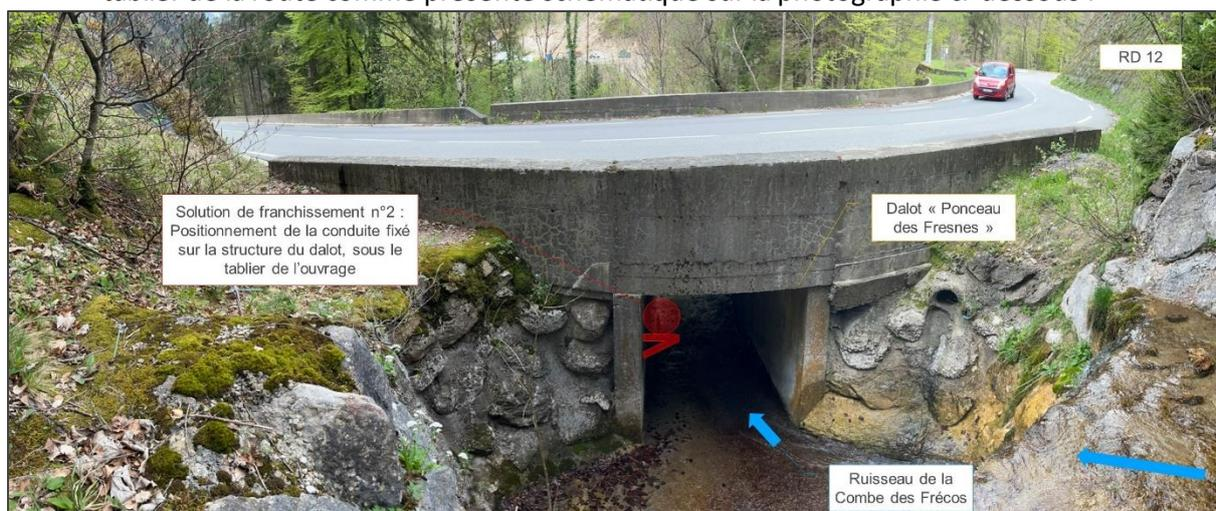
La solution n°2 consiste à fixer la conduite au plafond de l'ouvrage. Cette solution n°2 permettrait de limiter tout risque de création d'embâcle en ne diminuant pas la capacité d'écoulement des crues.
