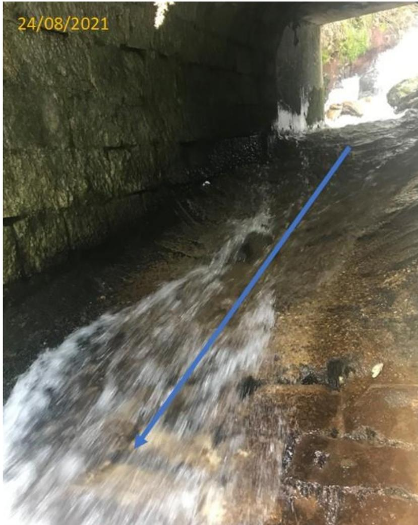
21 Passage sous la RD12 du cours d'eau issu des sources de la Puya : radier à très faible rugosité sur les 7 m de franchissement de la RD12
