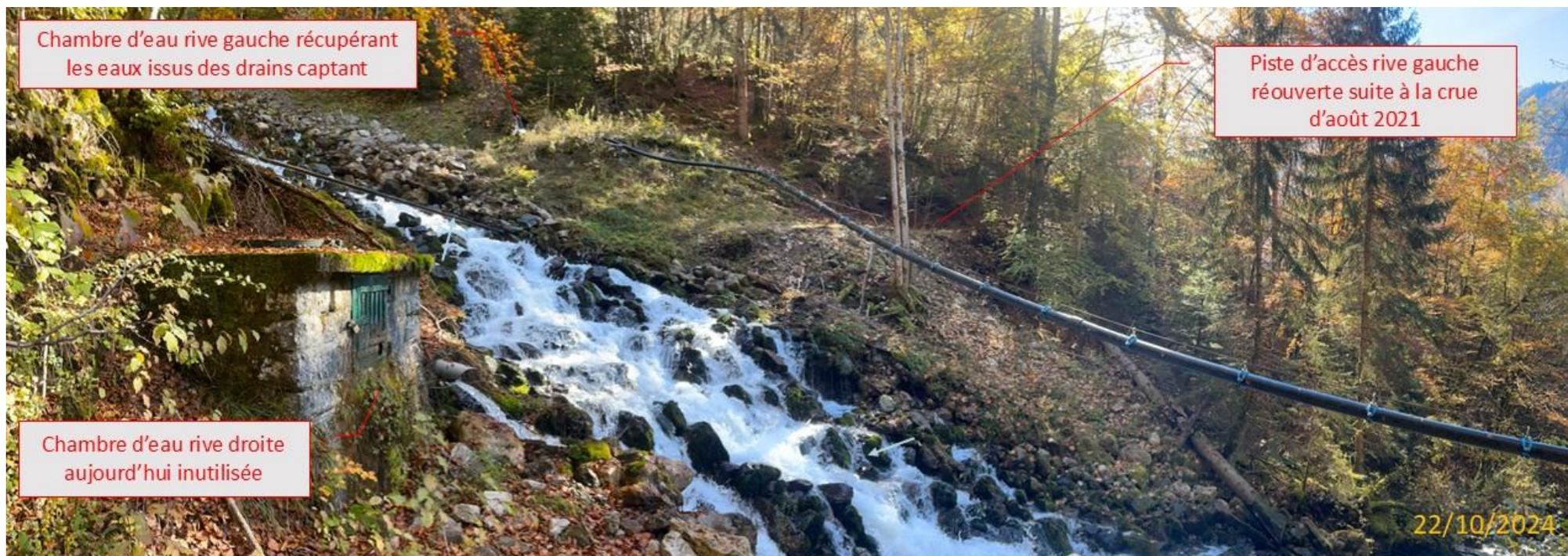
4 Vue depuis la rive droite du cours d'eau. La piste d'accès au captage AEP en rive gauche a été réouverte dans le cadre des travaux d'urgence réalisés par la régie de Faucigny Glières en Aout-Septembre 2021.
