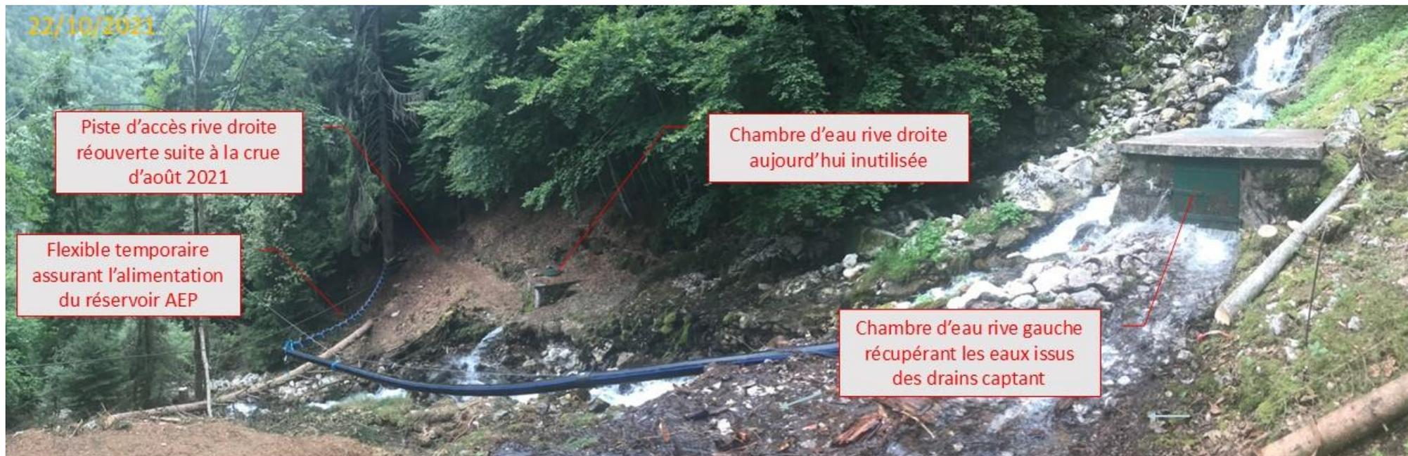
1 Vue depuis la rive gauche du cours d'eau. Le captage a subi des travaux d'urgence en août 2021. Des travaux sur le captage communal AEP seront programmés en même temps que les travaux pour le projet hydroélectrique de la Puya
