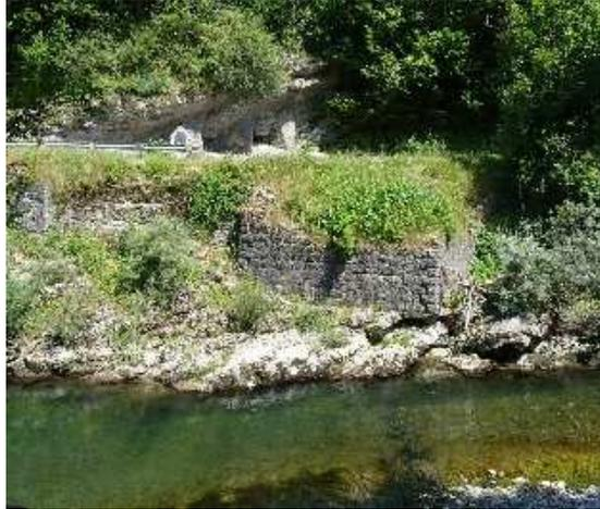
On réhausse la maçonnerie de cette culée « triangulaire » pour que cette « boîte » retrouve une fonction de parement cohérente avec les murs, nombreux, qui accompagnent le Fier à cet endroit. La forme dégage une large et confortable plate-forme d'accueil à l'entrée de la passerelle. Un balcon au-dessus du fier qui pourrait être agrémenté de bancs, voire d'une table d'orientation !
