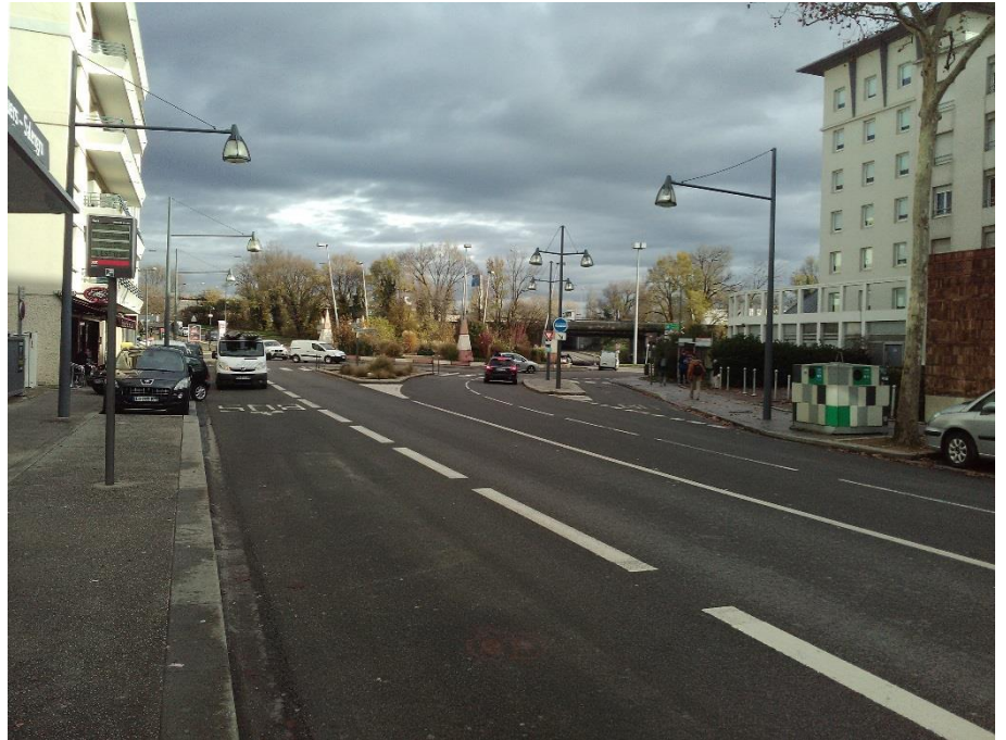
N°4 (12/2018) - Giratoire Charles de Gaulle vue vers l'est depuis l'avenue R. Salengro
