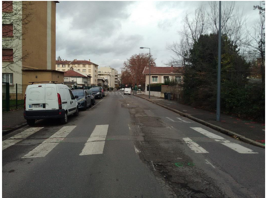
N°22 (12/2018) - Rue du 8 mai 45 vue vers le nord, aux abords de la rue E. Cheysson
