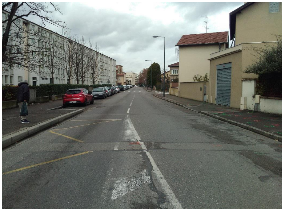
N°24 (12/2018) - Rue du 8 mai 45 vue vers le nord, aux abords du n°119
