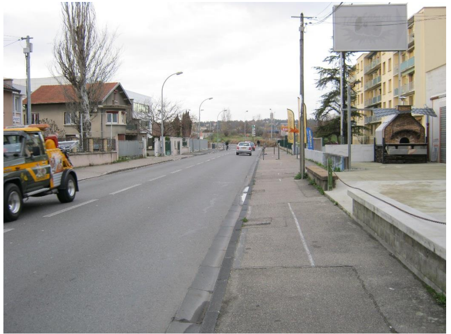
N°2 (01/2016) - Rue de la Feyssine vue vers le nord à proximité du n°49
