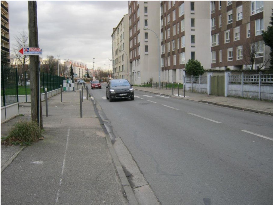
N°3 (01/2016) - Rue de la Feyssine vue vers le sud à proximité du n°49
