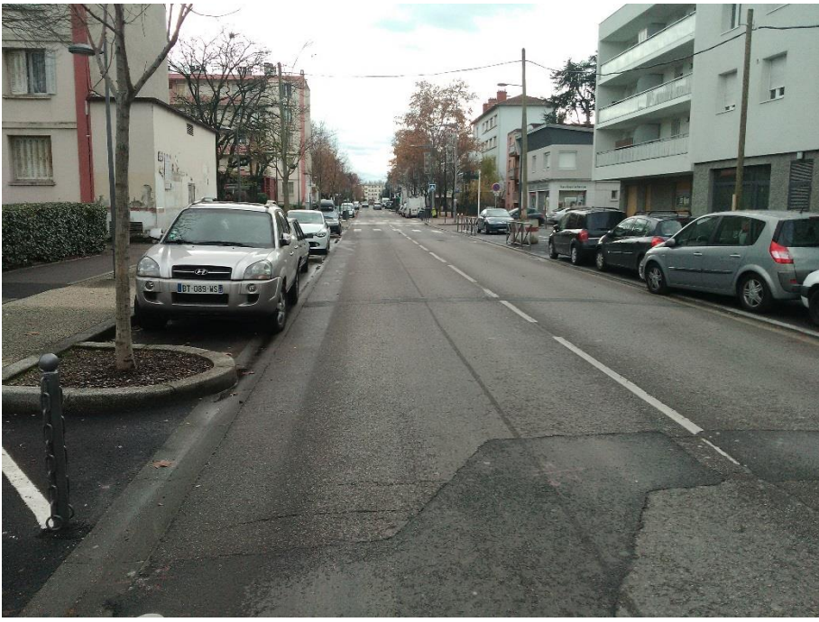
N°9 (12/2018) - Rue du 8 mai 45 vue vers le sud, au niveau de la rue de la Boube
