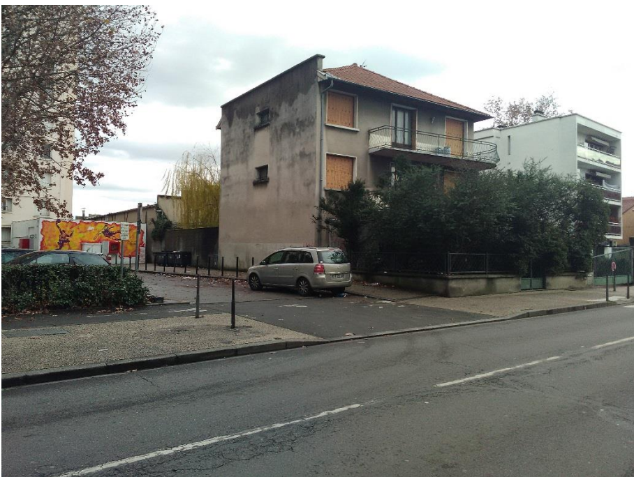
N°15 (12/2018) - Débouché du prolongement de la rue de la Boube sur la rue du 8 mai 45
