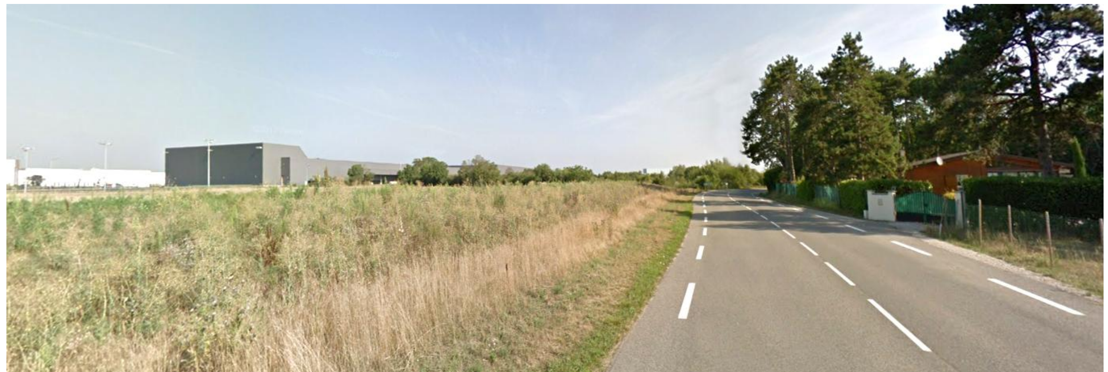
VUE 02 - Route de Lagnieu - Août 2017
