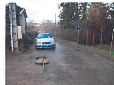
DO SB1 - Vue extérieure
