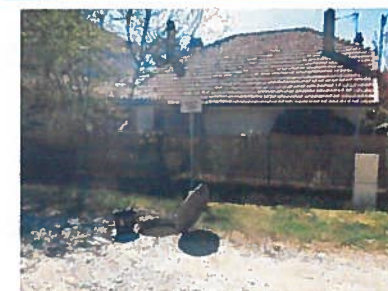
DO SB7 - Vue extérieure
