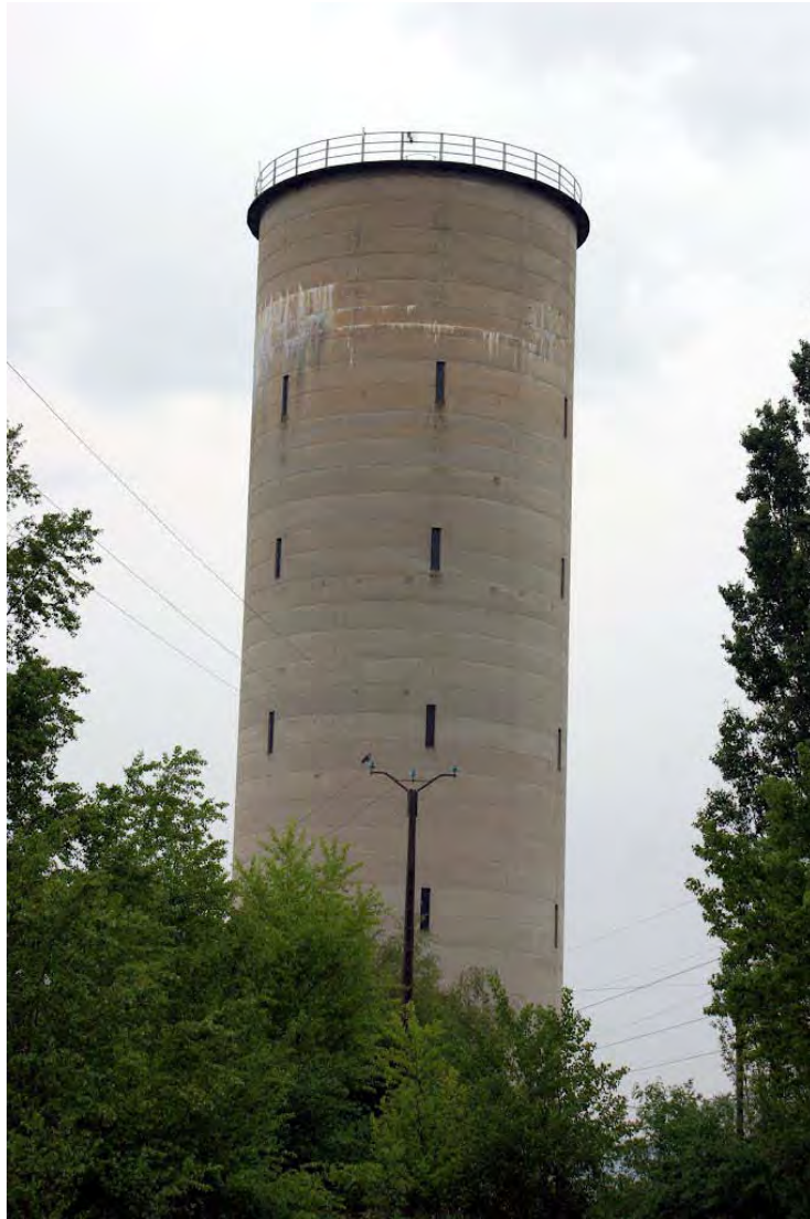
Illustration 1 : Le puits de Thil et son château d'eau (source : I. Lefevre)
