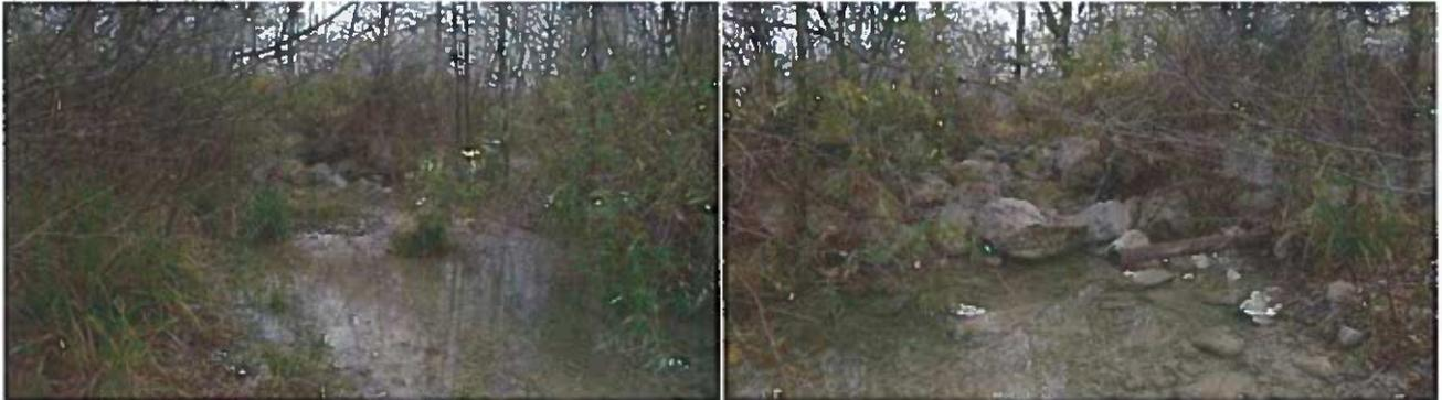
*Infiltration de la rivière vers le lac à travers la digue de séparation, en angle amont du lac*
