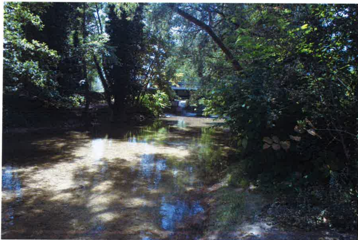
Vue 4 : vue sur le pont SNCF depuis la rive droite (Source : EPODE Juin 2017)
