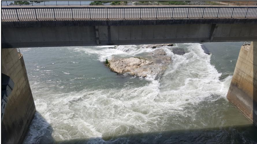
Figure 7 : conditions hydraulique et courants traversiers au droit de la passe 2 lors du passage du débit réservé par sousverse de la passe 1
