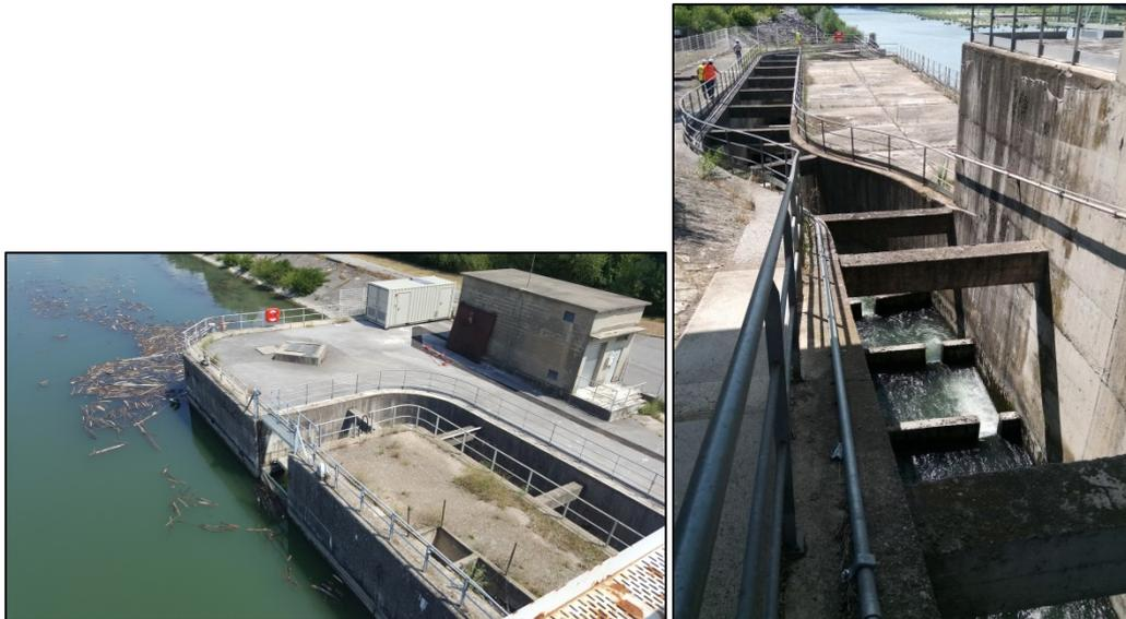
Figure 4 : prise d'eau et passe à poissons à bassins en fonctionnement
