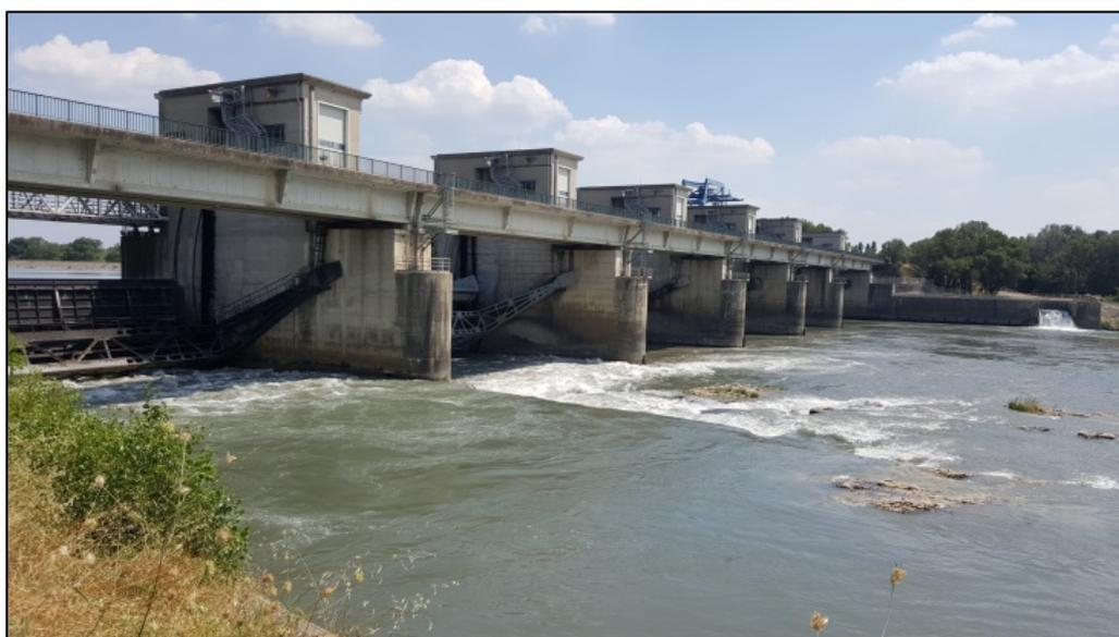
Figure 6 : conditions hydrauliques à l'aval du barrage lors du passage du débit réservé par sousverse de la passe 1, vue depuis la rive droite
