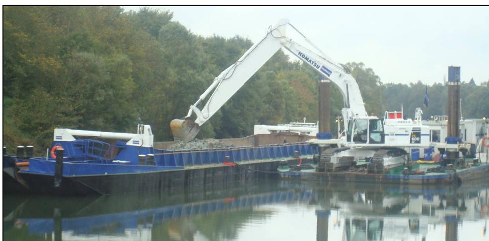
Figure 15 : exemple de chargement d'un chaland à l'aide d'une pelle à bras long installée sur un ponton
