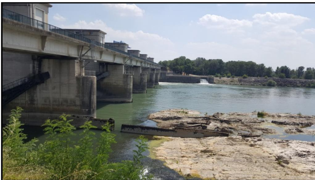
Figure 5 : conditions hydrauliques lors du passage du débit réservé par sousverse de la passe 6, vue depuis la rive droite
