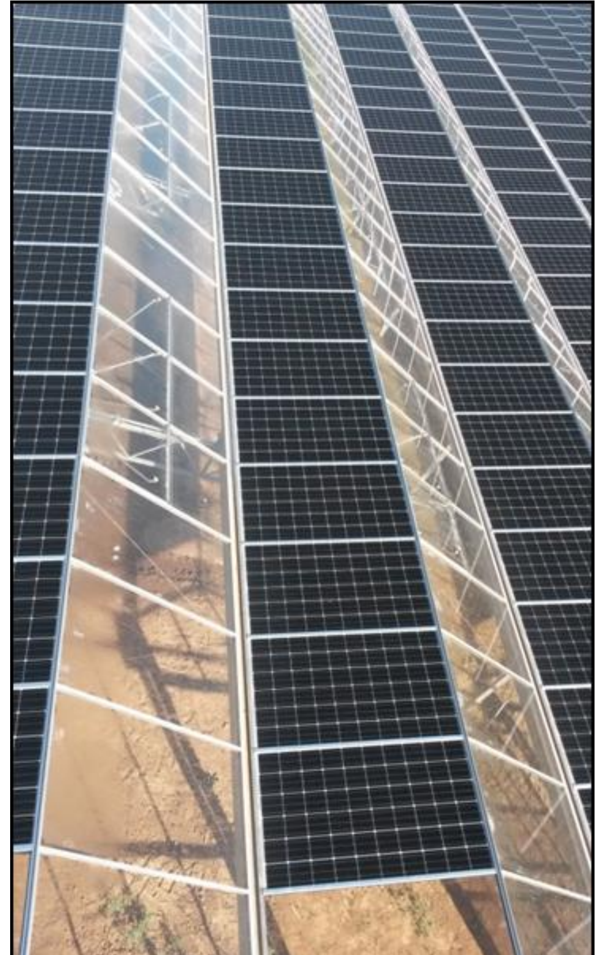
Pans nord vitrés Pans sud équipés de panneaux photovoltaïques
