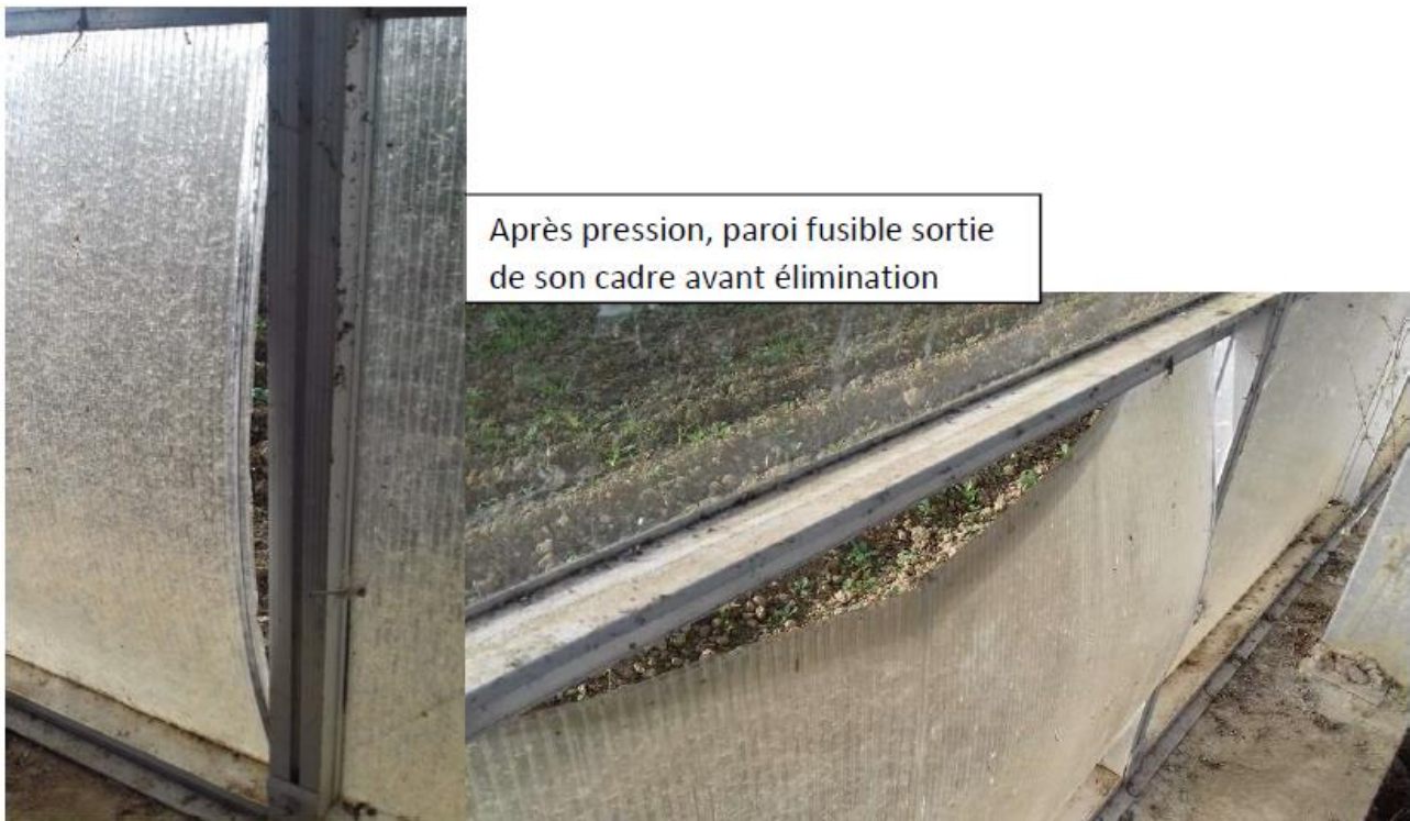
Figure 23 : Etat de la paroi fusible après pression exercée
