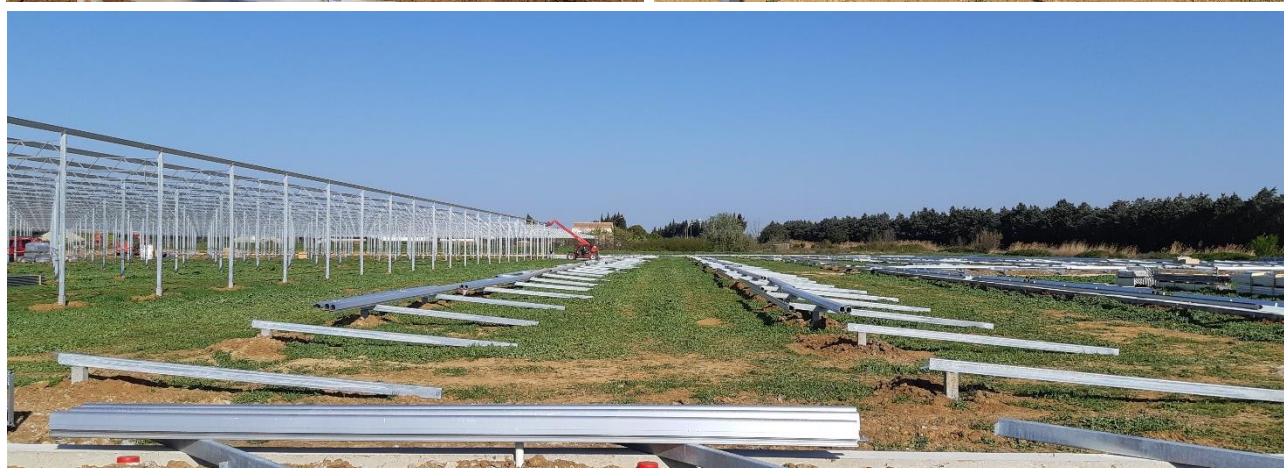
Figure 15 : Montage structure d'une serre photovoltaïque - Source : Reden Solar
