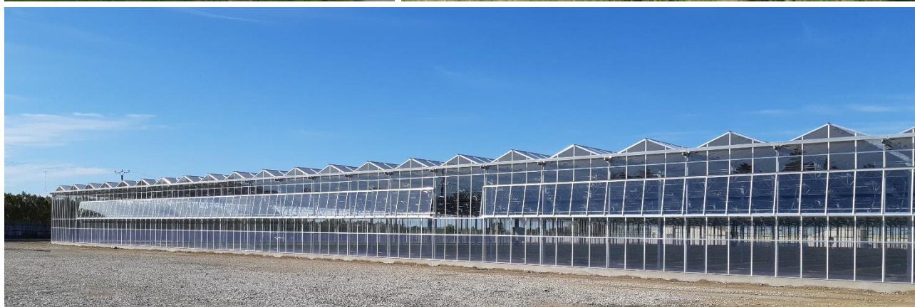
Figure 16 : Ouvrants en façade - Source : Reden Solar
