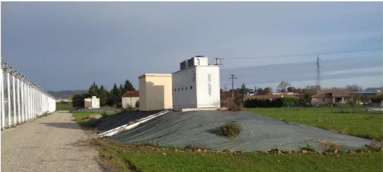
Figure 24 : Rehausse des équipements électriques lors d'un projet de serre en zone inondable
