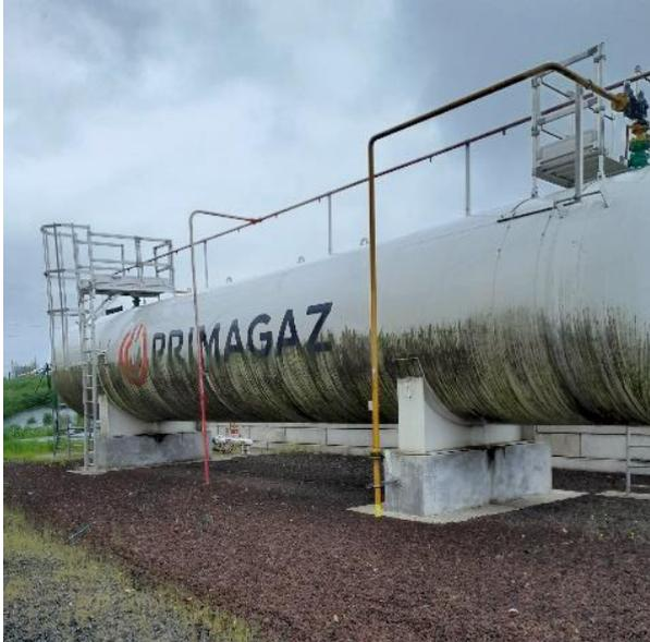
Le réservoir est associé à un vaporiseur (système d'échange de chaleur qui permet de maintenir la pression dans le réservoir quel que soit son niveau de remplissage et la température extérieure, afin de permettre de soutirer du gaz de façon continue en haut de la cuve).
