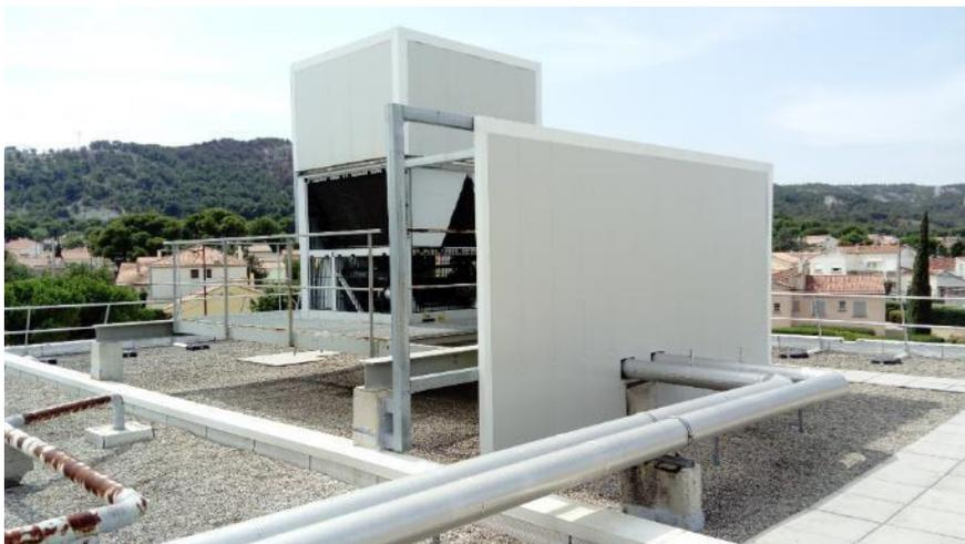
*Figure 4 : exemples de traitement avec écrans sur les côtés*
