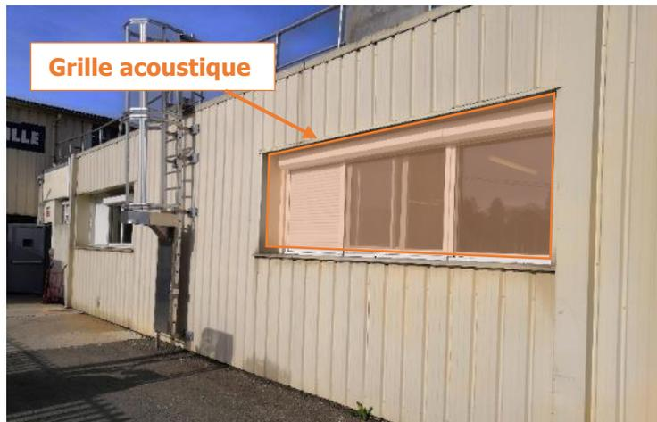
Cette grille permet d'assurer la ventilation d'air en vrac du local écrémeuse, tout en apportant une atténuation acoustique au droit de l'ouverture.
