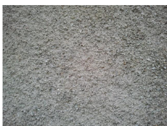
Enduit à la chaux au balai.
