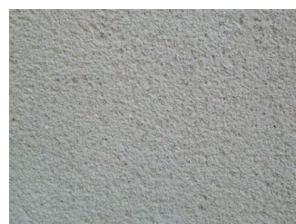
Enduit à la chaux gratté fin.
