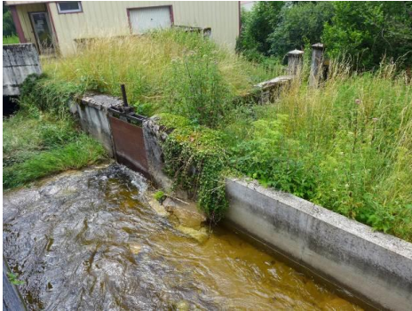
Section artificielle en amont
