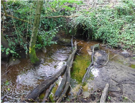
Buse d'écoulement de la mare
