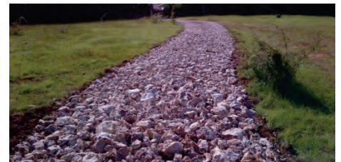
Ré-empierrement de la piste en TV de carrière 0-300
