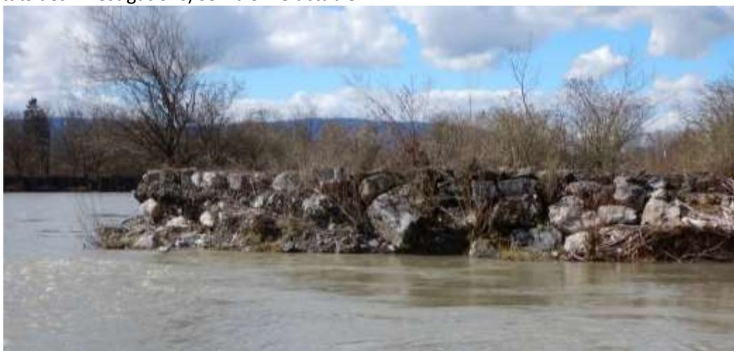
Tête de l'épi amont protégeant la RD14 dont le parement en enrochement a en partie disparue
