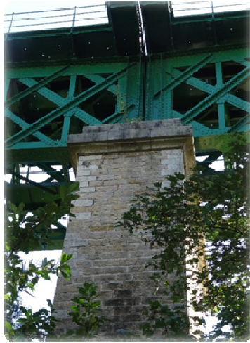
Les piliers du Viaduc ferriviaire sont très jointés et sont globalement peu favorables aux Chiroptères fissuricoles (P. Giraudet © Biotope)
