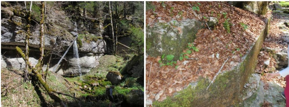
**Figure 9 : sortie de la canalisation et passage de la conduite dans un ouvrage maçonné en rive droite du ruisseau**
