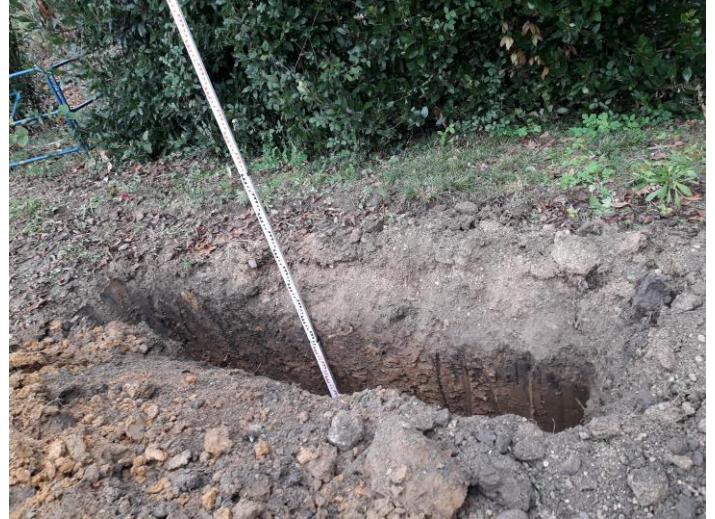
Vue du fond de fouille
