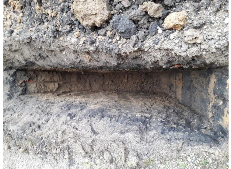
Vue du fond de fouille
