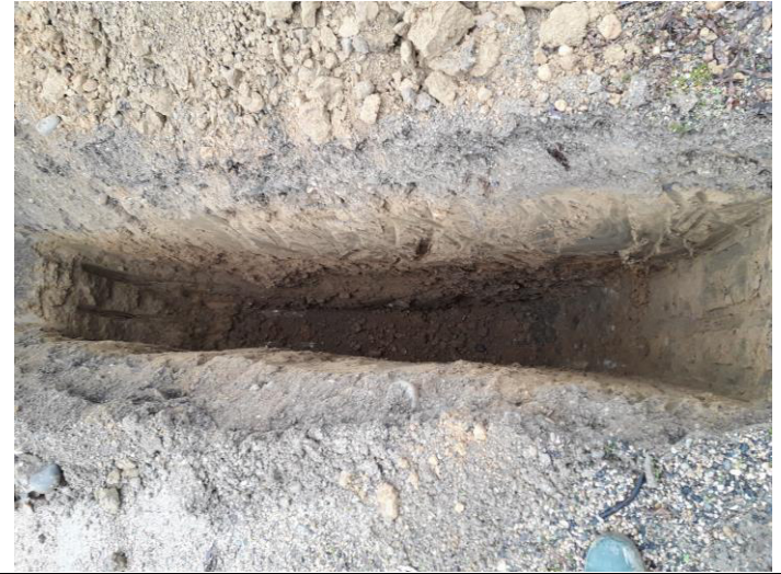
Vue du fond de fouille
