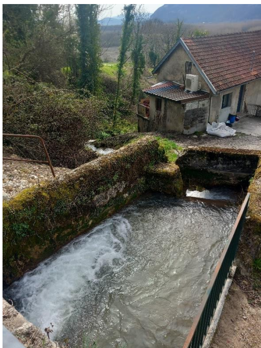
Réservoir de l'ancien moulin
