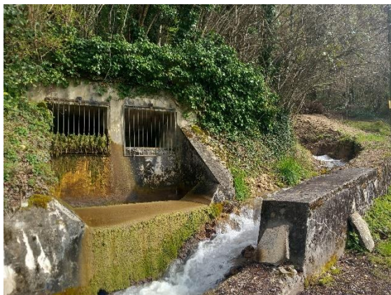
Jonction avec la conduite forcée
