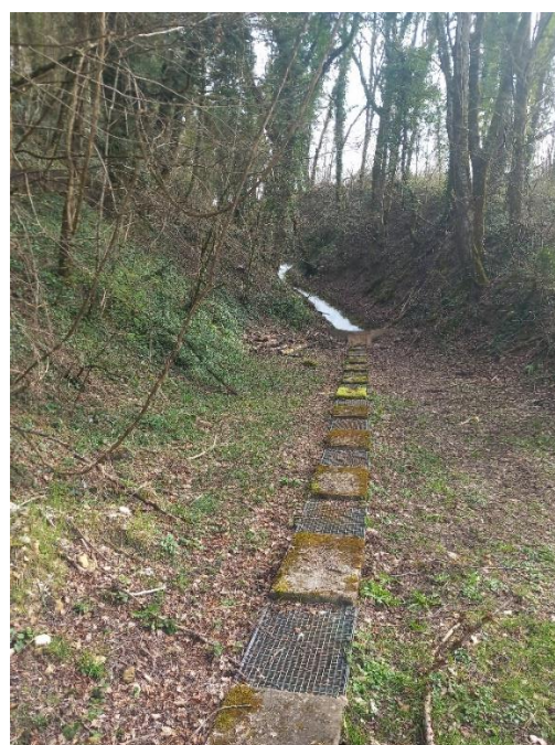
Ouvrages de canalisation des écoulements du RTM
