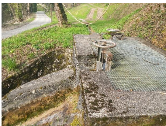
Ouvrage de dérivation des écoulements par vannes en amont de la cascade des tufs
