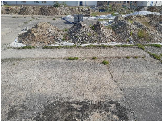
Plateformes bétonnées et remblais sur le site KemOne Nord
