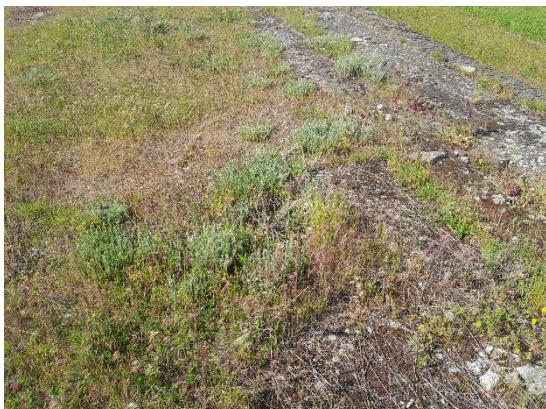
Friches sèches sur ancien bâtiment sur le site KemOne Nord
