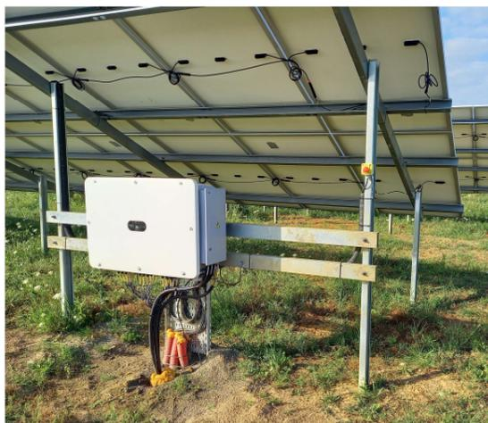
Figure 21 - Exemple d'onduleur
