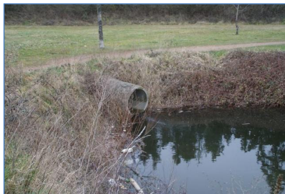
Conduite de rejet pluvial
