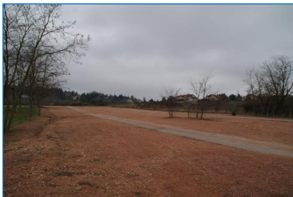
Parking en sable compacté
