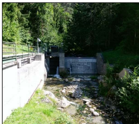
Figure 4 : Prise d'eau de Naves (photographie depuis l'aval)
