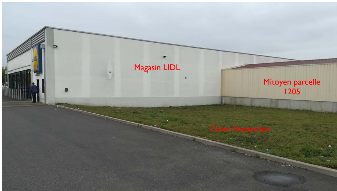
Photographie du site – vue générale : jonction entre le magasin LIDL et le mitoyen de la parcelle 1205
