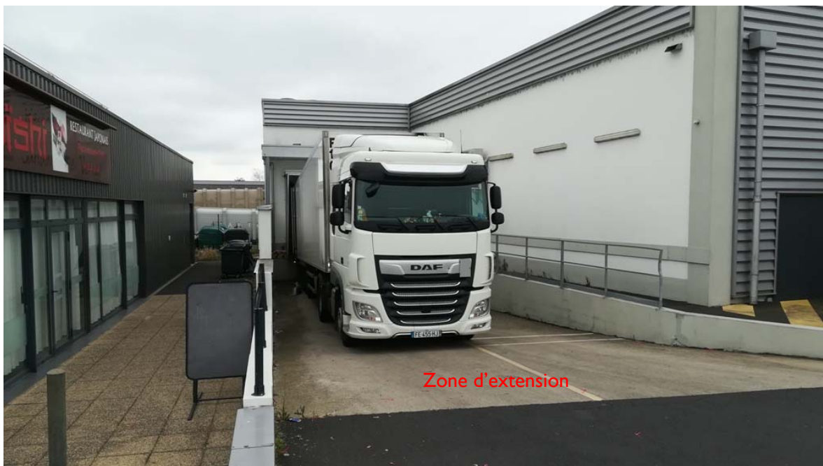
Photographie du site – vue générale zone du quai existant
